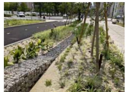
中央通り再編事業で整備した雨庭
