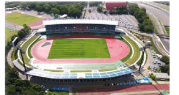
ネーミングライツを導入している三重県総合競技場（伊勢市）
